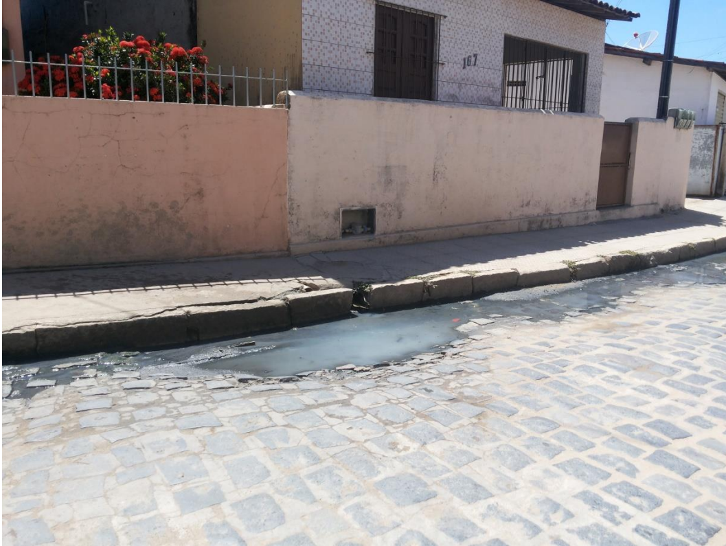
Figura 34: Lançamento de esgoto a céu aberto no Centro
