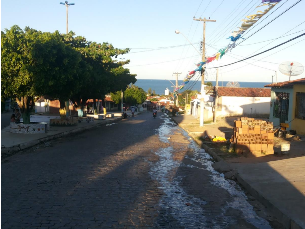
Figura 36: Esgoto a céu aberto em Pitimbu
