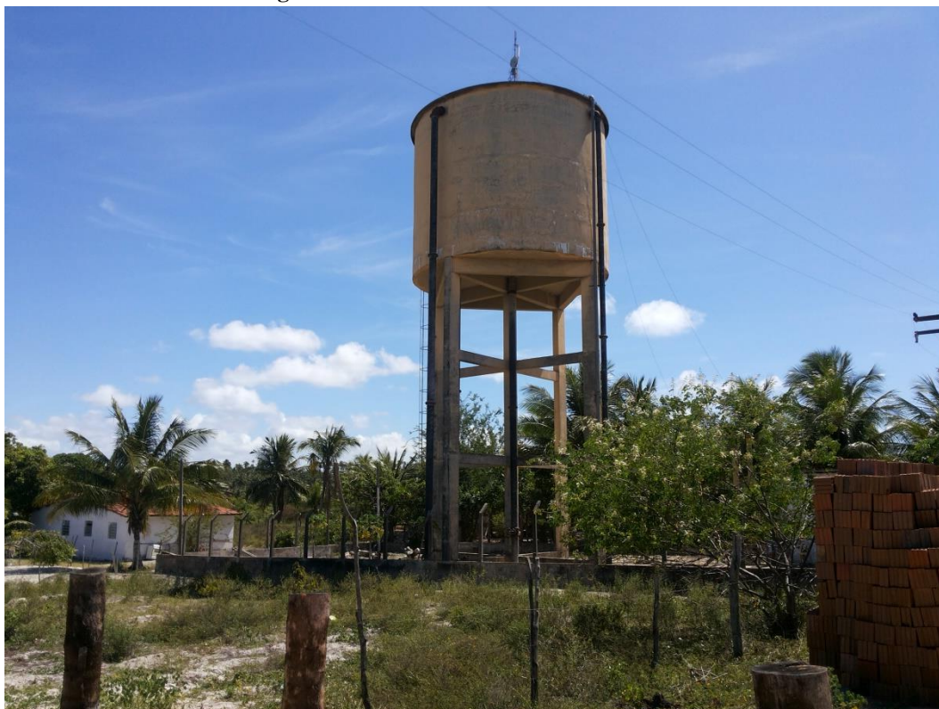
Figura 29: Reservatório de Sítio das Cruzes
