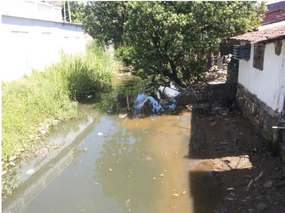
Figura 33: Lançamento de esgoto no Rio Maceió
