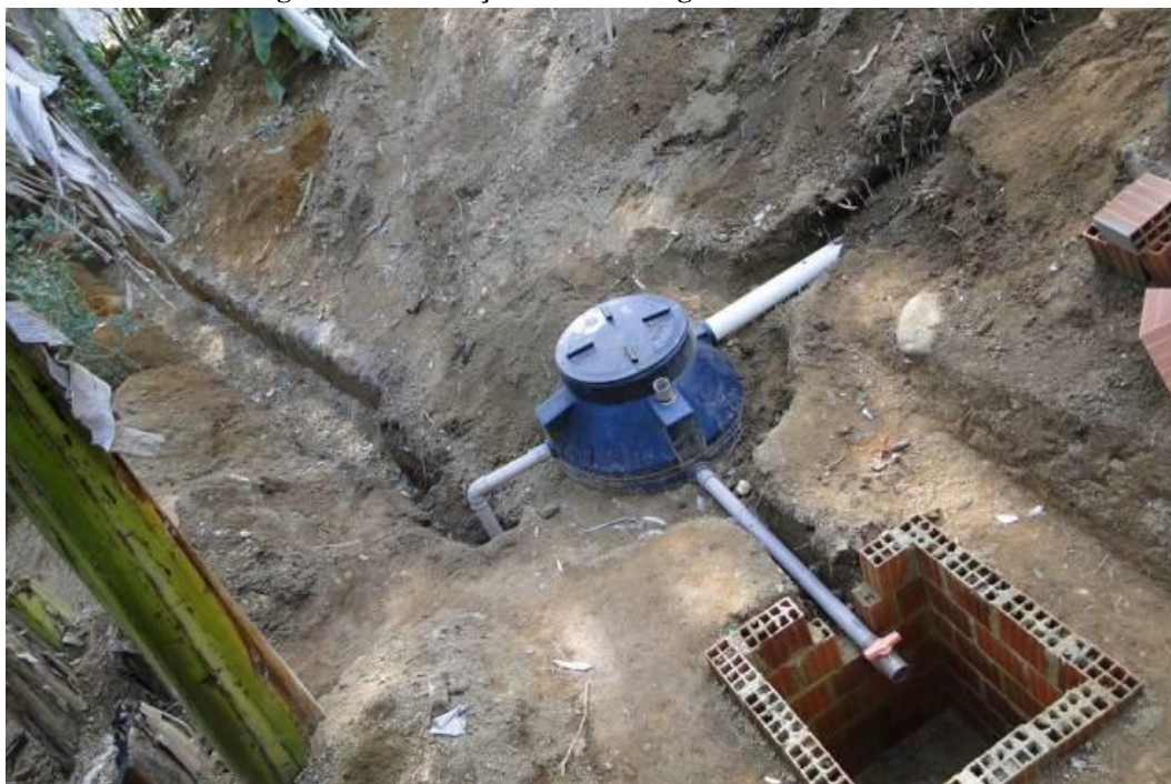
Figura 52: Instalação de um biodigestor em zona rural
