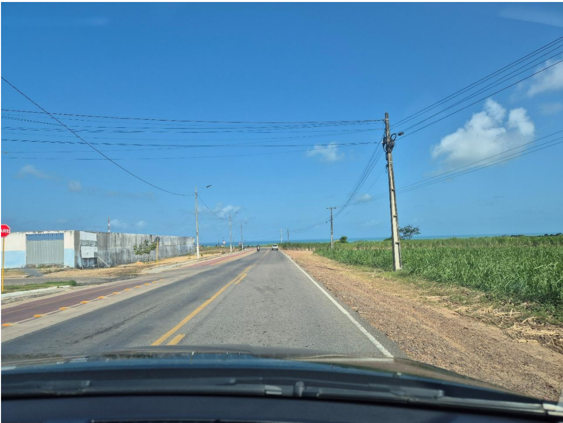
Figura 4: Exemplo de trecho rodoviário com ciclofaixa observada (PB-044)
