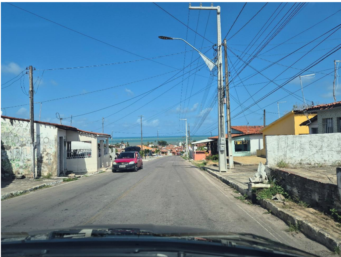
Figura 12 - Exemplo de calçada em Pitimbu sem condições de caminhabilidade e de acessibilidade (Rua do Campo)
