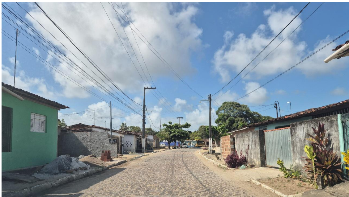
Figura 11 - Exemplo de via sem calçada ou com calçada obstruída por materiais de construção (Taquara)
