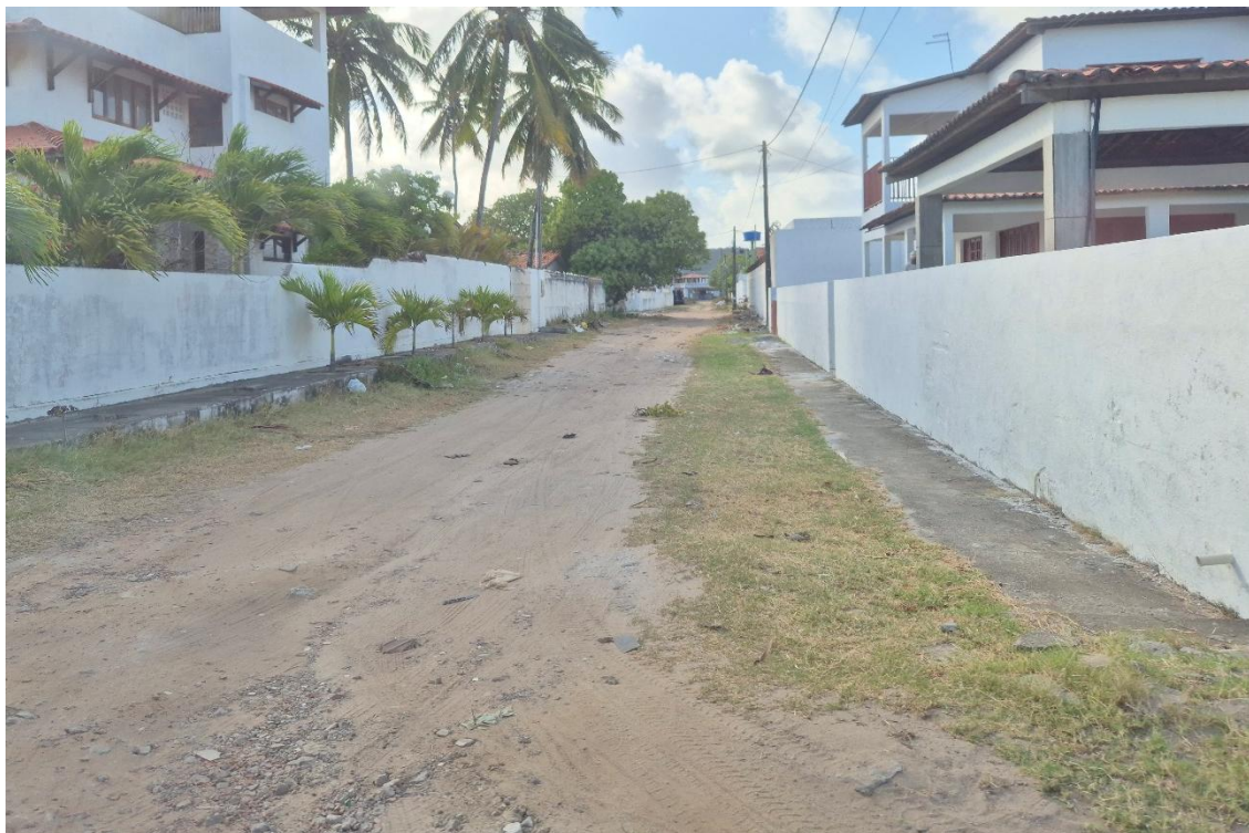
Figura 5 - Exemplo de via urbana sem pavimentação (via sem nome)
