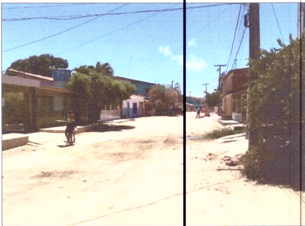
Foto 1 – Início do trecho a pavimentar.
