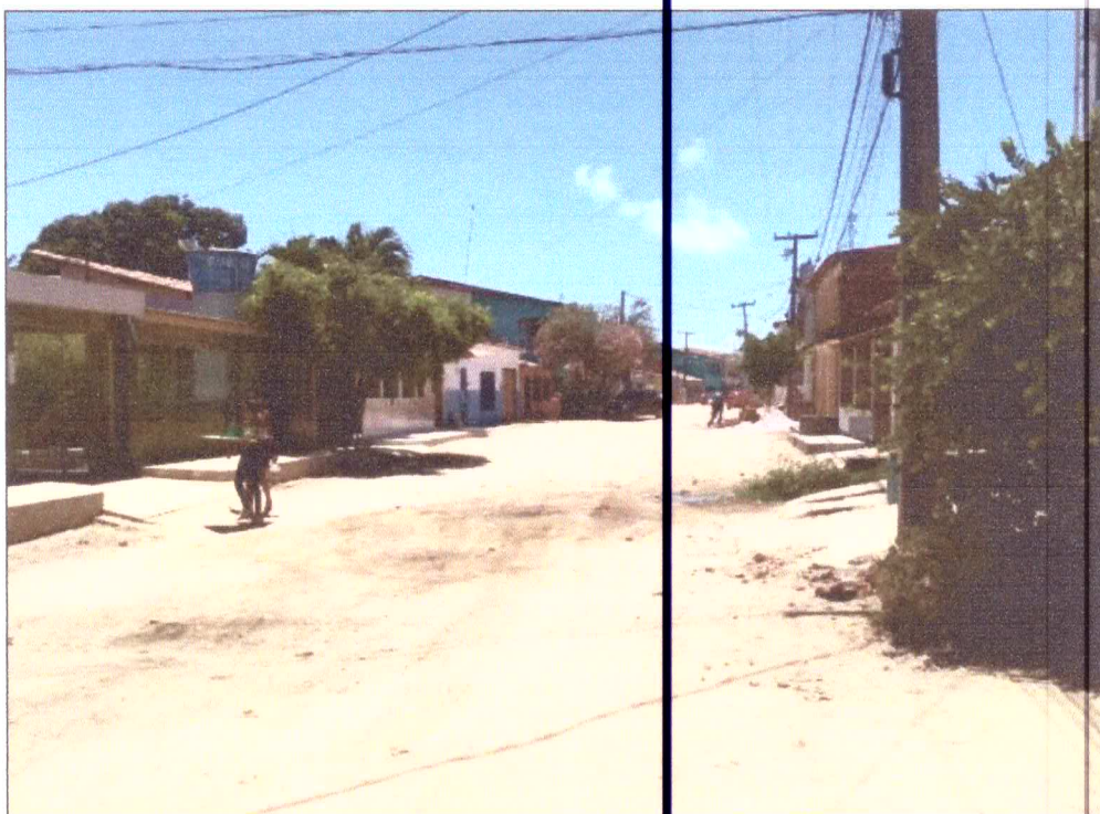
Foto 1 – Início do trecho a pavimentar.
